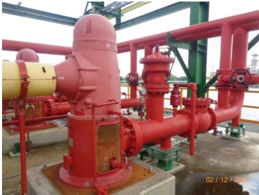
รูปที่ 3.49 เครื่องสูบน้ำดับเพลิง
