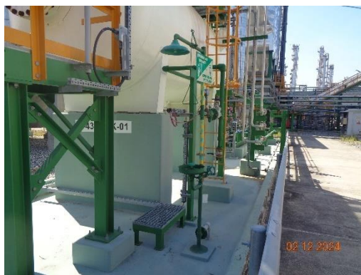
รูปที่ 3.45 อ่างล้างตาและร่างกายในบริเวณกระบวนการผลิต
