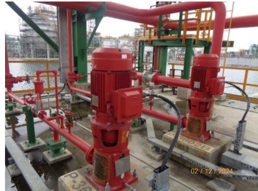
รูปที่ 3.49 เครื่องสูบน้ำดับเพลิง
