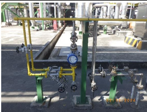
รูปที่ 3.41 ระบบก๊าซไนโตรเจนเพื่อปิดคลุม (Nitrogen Blanketing)
