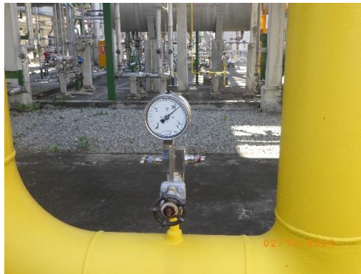
รูปที่ 3.55 Pressure / Temperature Indicator
