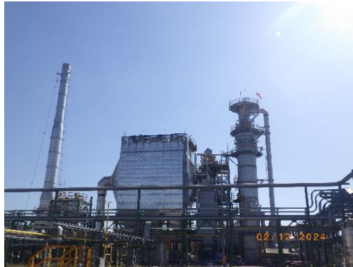
รูปที่ 3.21 Dust Removal Unit
