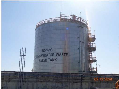
รูปที่ 3.13 ถังเก็บน้ำเสียของระบบเผาทำลาย (TK-1693 และ TK-1694)
