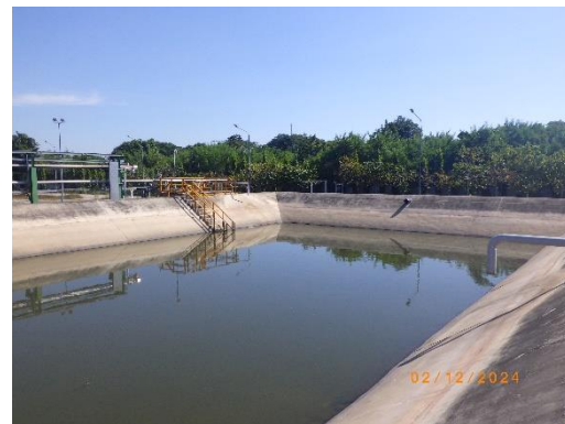
บ่อตรวจสอบคุณภาพน้ำระบายทิ้งจากหอหล่อเย็น (Cooling Water Blowdown Check Basin)
